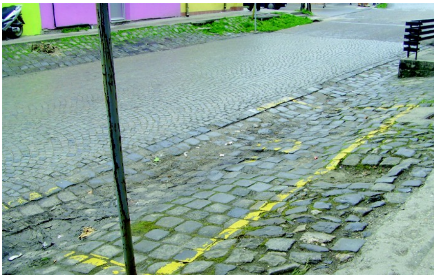
Ulica Nemanjina (parking mesto za osobe sa invaliditetom)
